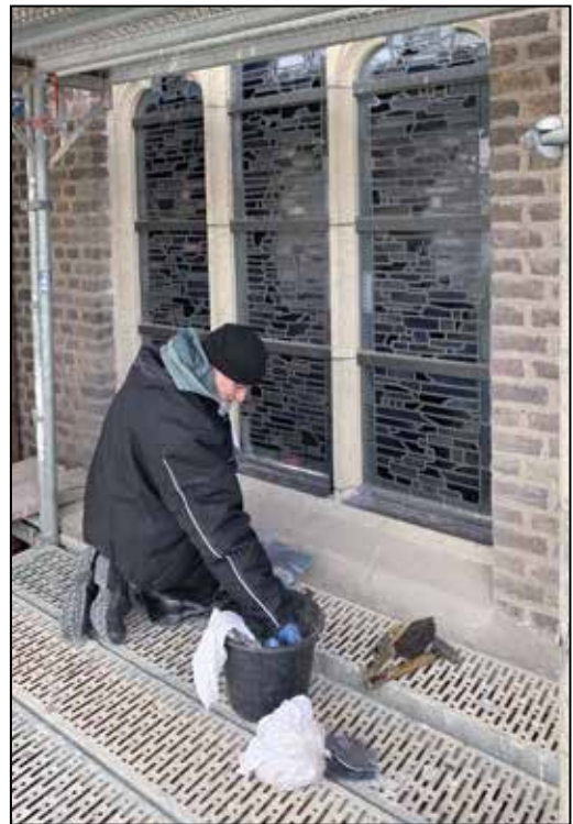
Die Maßwerkfenster sind eingesetzt, ein Handwerker reinigt und verfügt sie sorgfältig.
