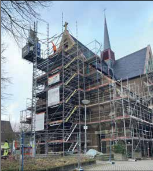
Die Arbeiten an der St.-Barbara-Kirche gehen sichtbar voran. Noch ist das Gotteshaus von einem dichten Gerüst umgeben, doch Dach und Turm präsentieren sich bereits in neuem Glanz.
