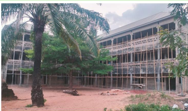
Das zweistöckige Schulgebäude befindet sich noch im Bau
