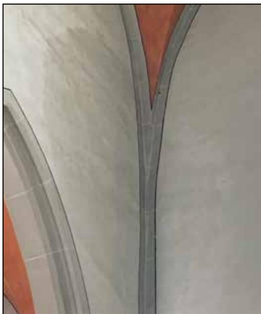
Feuchtigkeitsschaden in der Kirche, der durch das defekte Dach entstanden ist.
