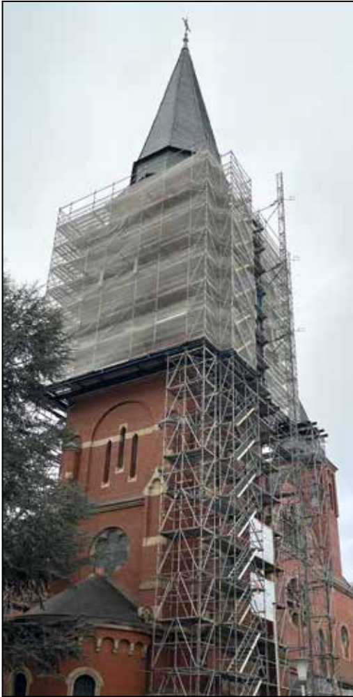
Ein letzter Blick auf das Gerüst der Kirche an der Kirschallee.
