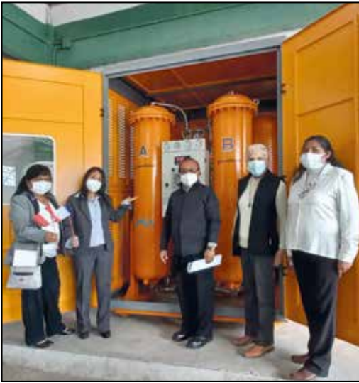
Bau einer Sauerstoffabfüllanlage in Peru.
