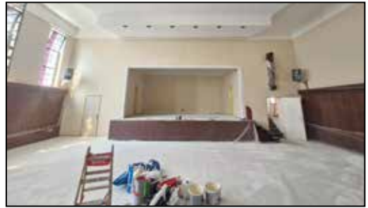
Während der Malerarbeiten im Pfarrsaal.
