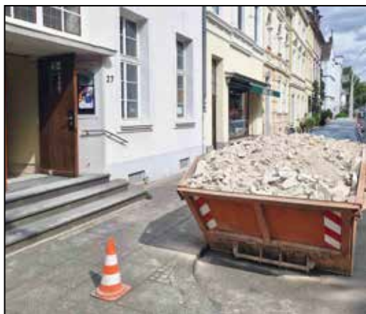
Der erste Container ist mit den alten Platten und dem schadhaften Estrich gefüllt.
