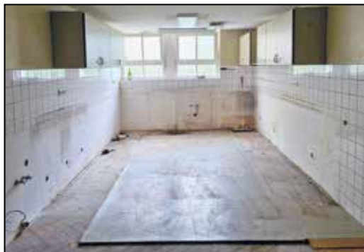
Die alte Saalküche ist schon fast vollständig ausgebaut.
