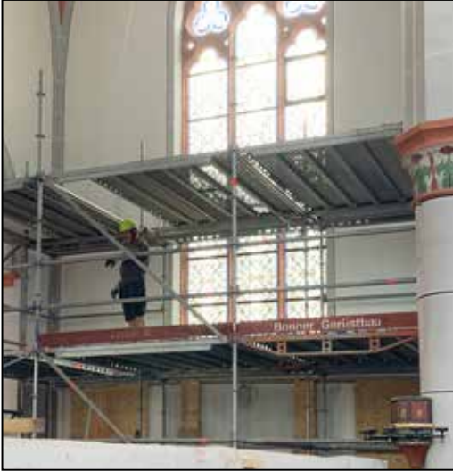
Abbau des Innengerüstes.
